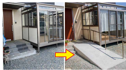
手すりスロープ追加で玄関出入りはスムーズに
